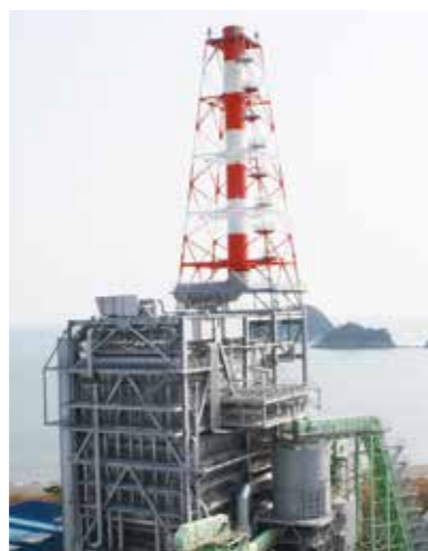
富冈工厂生物质能锅炉
