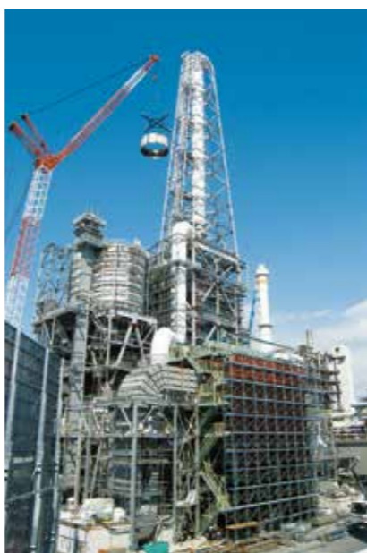
建设中的王子Materia富士工厂生物质能锅炉(静冈县)
