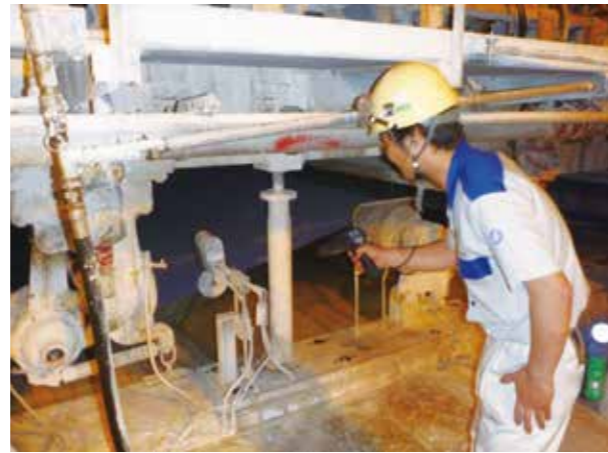
调查压缩空气泄露(王子制纸 米子工厂)
