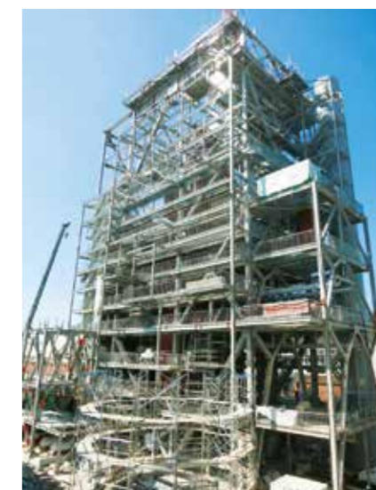
建设中的生物质能锅炉 (王子 Green Resources 日南/宫崎县日南市)
