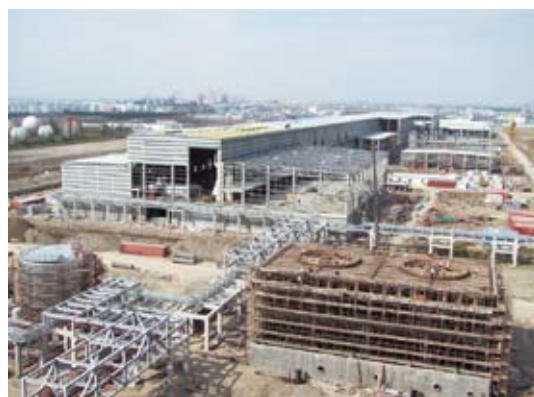
建设中的南通工厂
