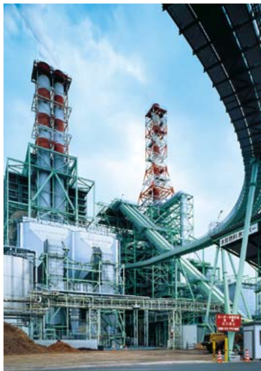
王子制纸米子工厂的新能源锅炉
